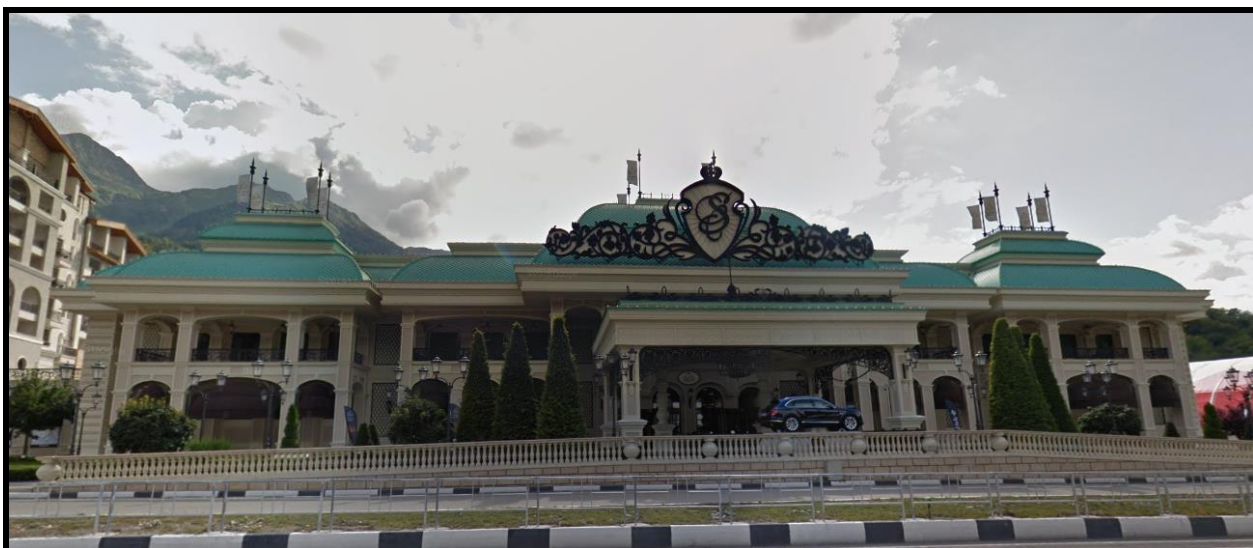
Рисунок 24 – Фасад здания с кадастровым номером 23:49:0420021:1097
