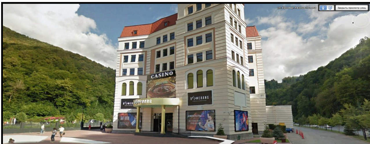
Рисунок 26 – Фасад здания с кадастровым номером 23:49:0512002:4369
